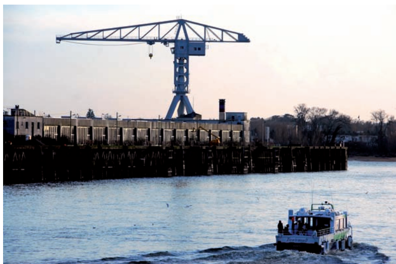
Sur l'île de Nantes, le Hangar à bananes en cours de transformation.
